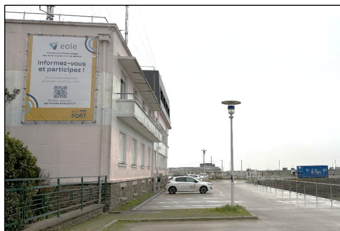
Bache sur la capitainerie de Saint-Nazaire
